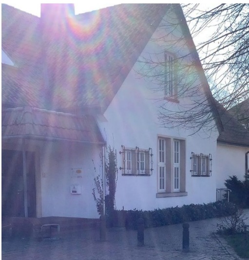
Abb. 22: Geteilte Räumlichkeiten der Messdienergemeinschaft und des Kindergartens
