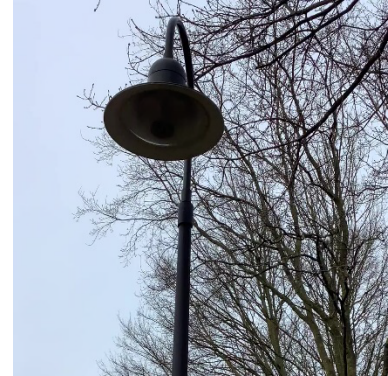
Abb. 46: An einigen Stellen fehlt eine ausreichende Stra- ßenbeleuchtung
