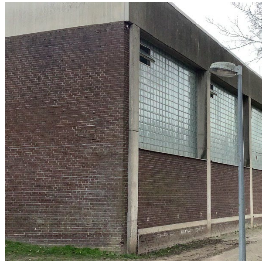
Abb. 44: In der Turnhalle fehlt ein behindertengerechtes WC
